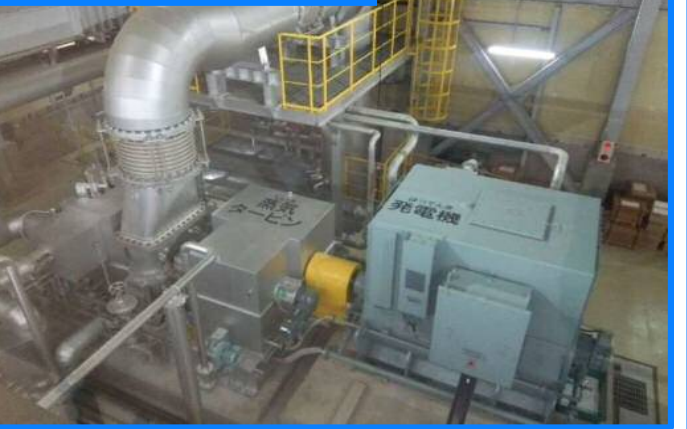
【 蒸気タービン発電機 】
